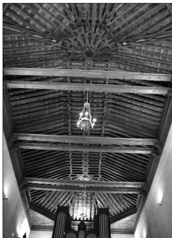
Armadura de la nave primitiva.
