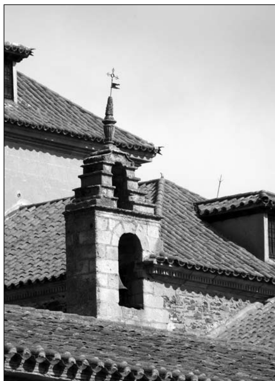
Espadaña de la antigua capilla mayor.
