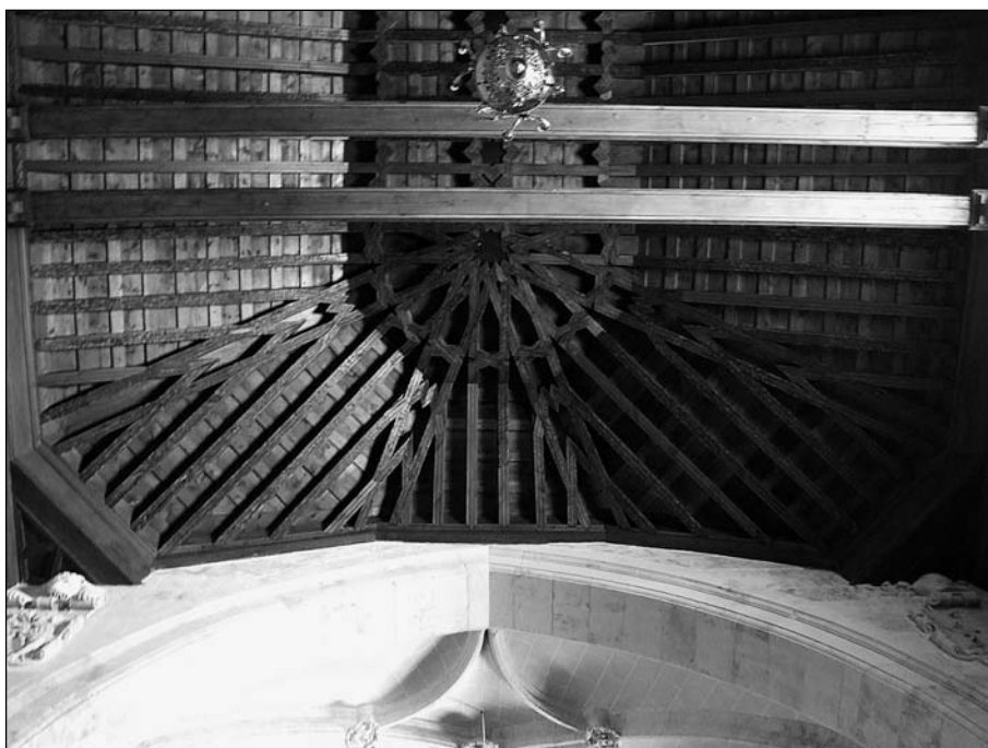
Arco toral entre la antigua capilla mayor de 1576 y la nave primitiva (la armadura está cortada por el nuevo toral).
