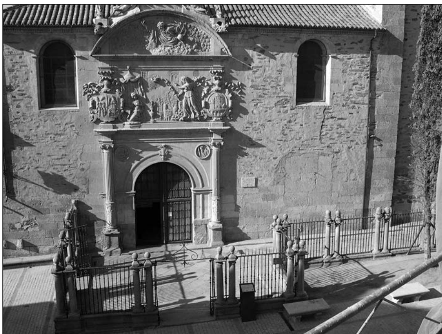
Atrio de cerramiento recrecido, puerta de la iglesia, puerta cerrada por el sepulcro de los Galarza, y sillares de esquina del templo y del arco toral de la antigua capilla mayor, que se montó sobre un extremo de la nave primitiva.
